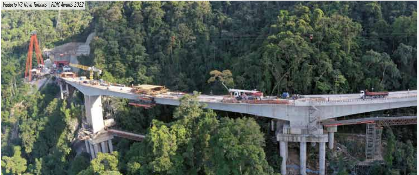
Viaducto V3 Nova Tamoios | FIDIC Awards 2022
