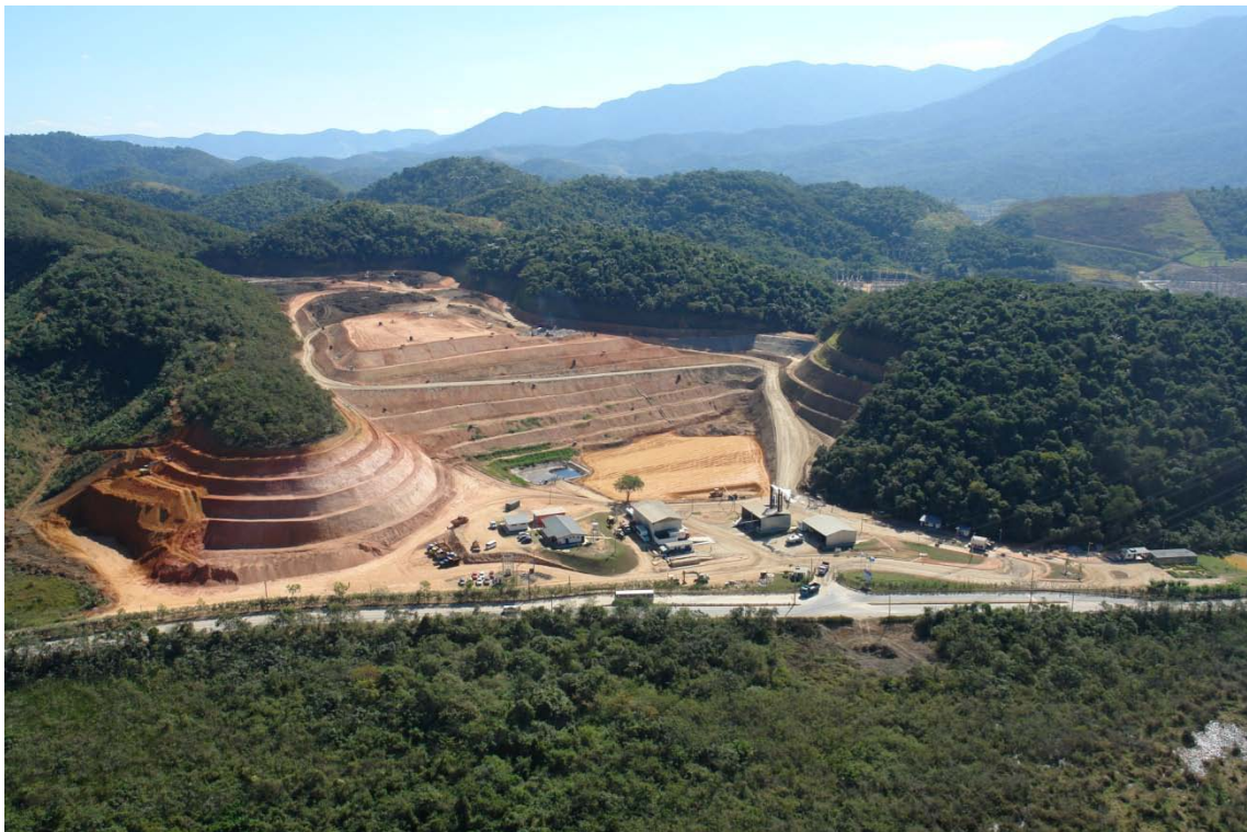
Aterro Sanitário Nova Iguaçu
