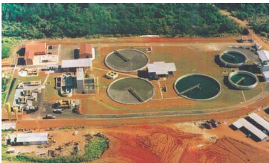
Estação de Tratamento de Esgoto - Itu
