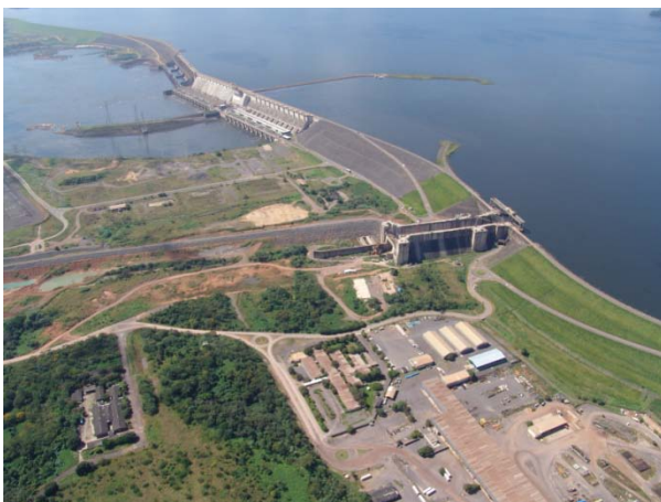
Compuerta de Tucuú
