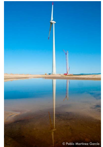
Parque Eólico de Tramandaí
