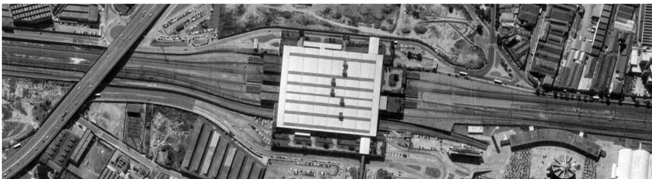
Adecuación de las líneas ferroviarias del CPTM
